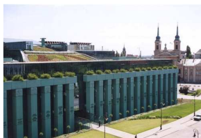
Budynek Sądu Najwyższego w Warszawie
